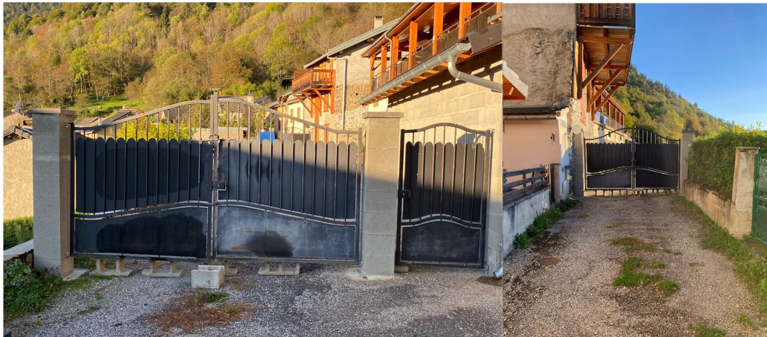
Portails fermant la voie 1
